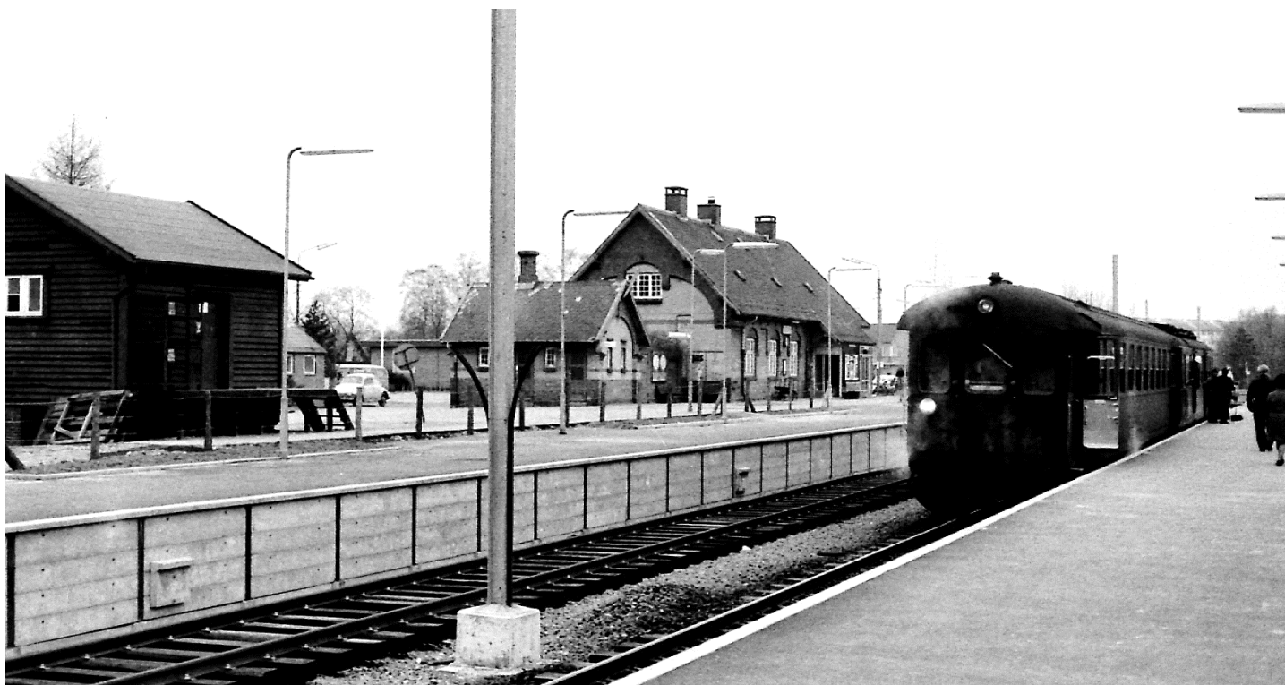
Nye perroner og spor ibrugtaget 4-2-1975 (A6300)
