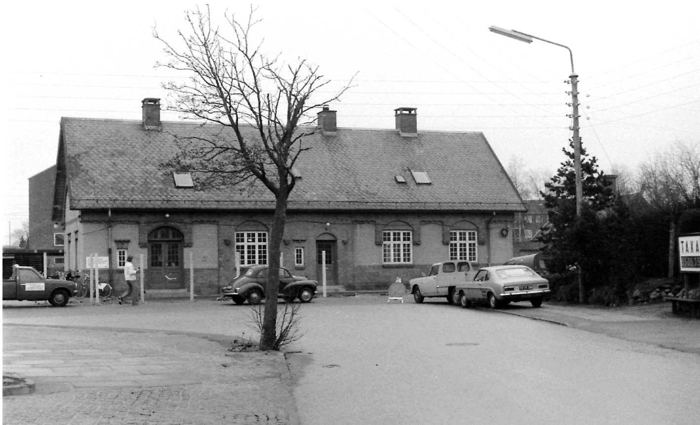
Den gamle stationsbygning er allerede ved at blive indhegnet 14-3-1977 (A9917)
