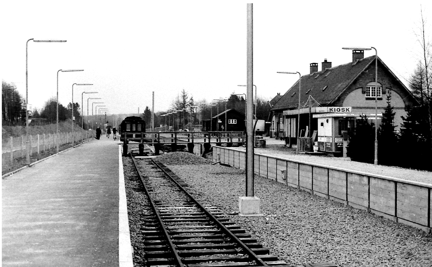
Midlertidig forbindelse mellem perronerne 4-2-1975 (A6302)
